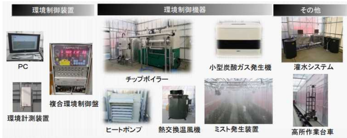
図3 岩手県農業研究センターの複合環境制御のシステム
