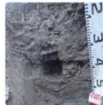
▲施工後断面（深さ500mm）
